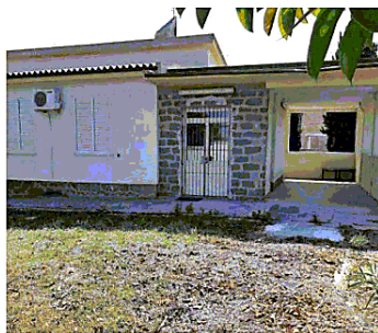
La scuola materna di Ottava. Per la riapertura saranno necessari ulteriori lavori della durata di un mese
